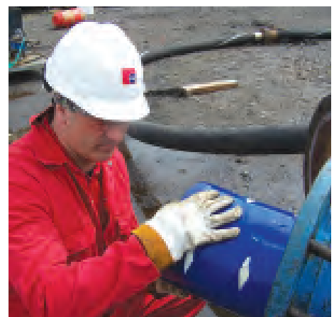
Пенополиуретановый снаряд загружается в трубопровод
