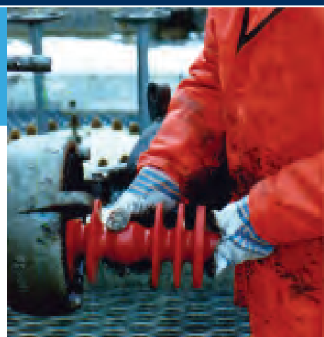
Цельнолитой скребок установлен в трубе
